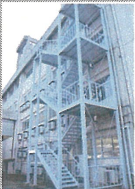
非常階段工事終了した非常階段の様子
